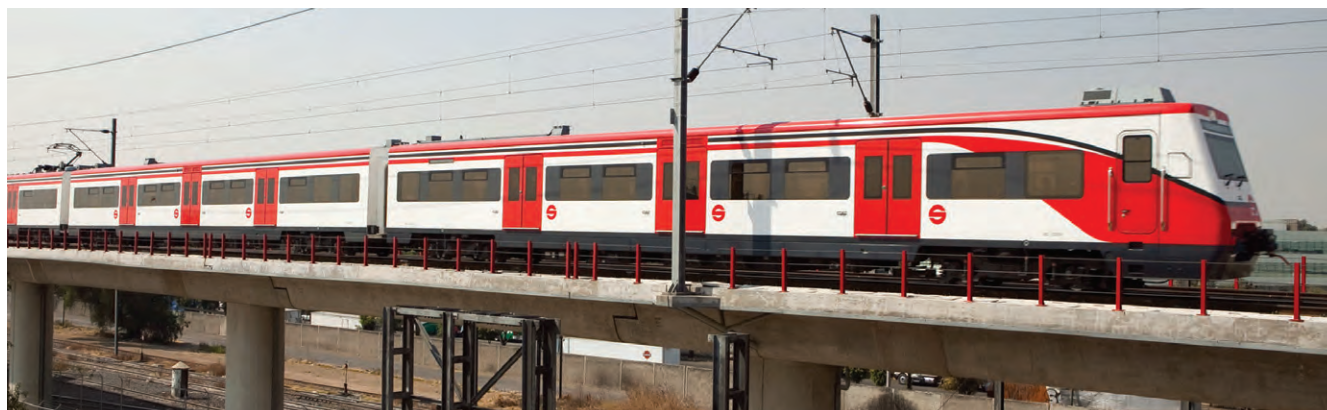
Tren Suburbano/Banco de imágenes SCT
