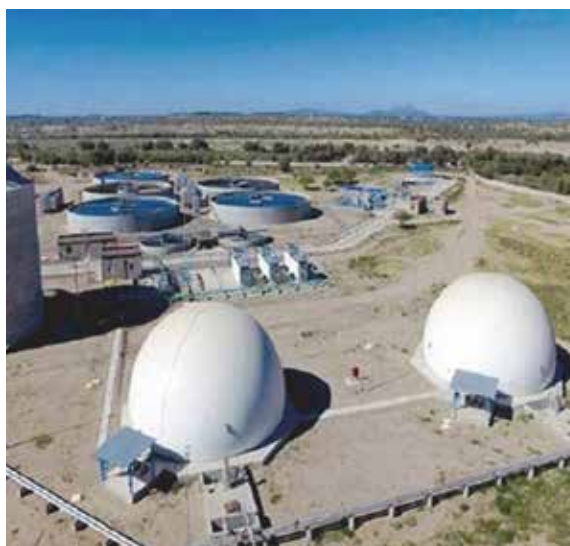
Figura 3.25. PTAR de lodos activados y recuperación de biogás en Hermosillo, Sonora
